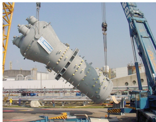
Slika 2 – Winkelson reaktor s fluidiziranim slojem za proizvodnju polietilena (izvor: https://psri.org )
