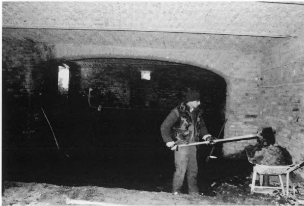
Građevinski radovi na pripremi drenaže zgrade Malančec, proljeće 2007.
