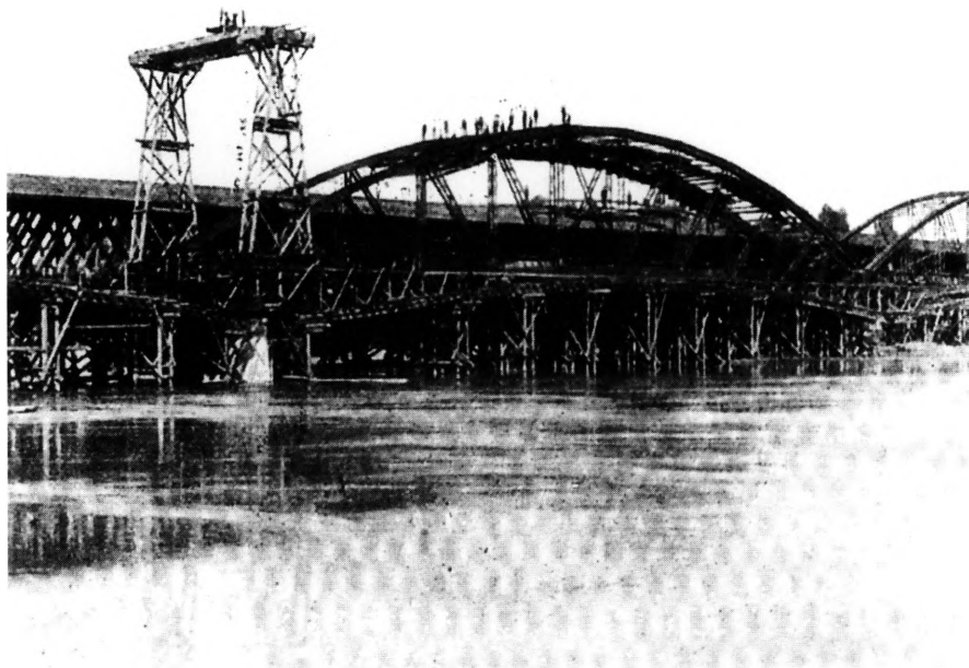
Radovi na zamjeni drvenog čeličnim mostom na Dravi kod Botova 1892. godine
