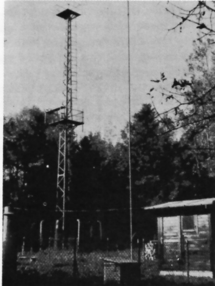
Slika 8. Metalni toranj visok 20 m i meteorološki krug za smještaj meteoroloških instrumenata i pisača na zemljištu Opservatorija Puntijarka, postavljen i pripremljen za rad tijekom 1959. g. (snimila I. Lisac 1965. g.).
