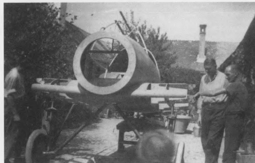
Trup turističkog aviona "Fizir F.T." u fazi izrade, koju nadgleda sam konstruktor.
