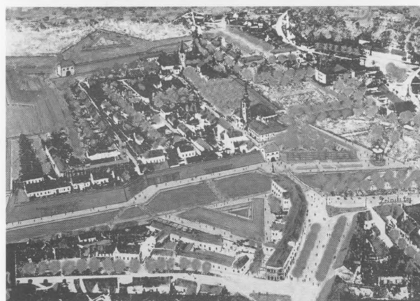
Slika 3. Revitalizacija koprivničke tvrđave, pogled sa sjevera
