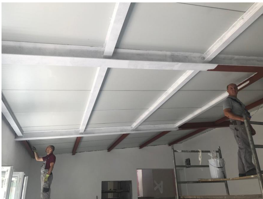
Slika 3. Nanošenje drugog sloja zaštitnog premaza na gradilištu
