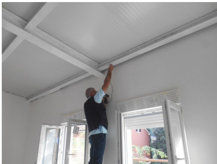
Slika 8. Kontrola debljine suhog filma drugog zaštitnog sloja na gradilištu
