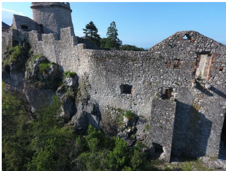
Slika 12. Sjeverni zid – uz Zapadni/stambeni dio kompleksa [7]
