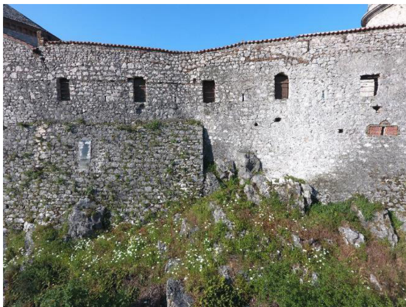
Slika 11. Sjeverni zid – uz Zapadni/stambeni dio kompleksa [7]
