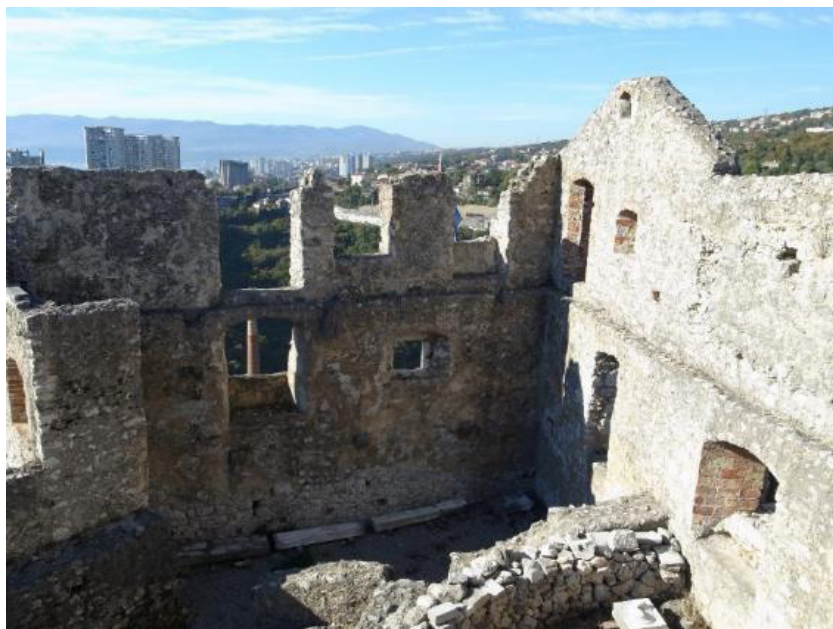
Slika 15. Zapadni/stambeni dio – pogled prema zapadu [7]
