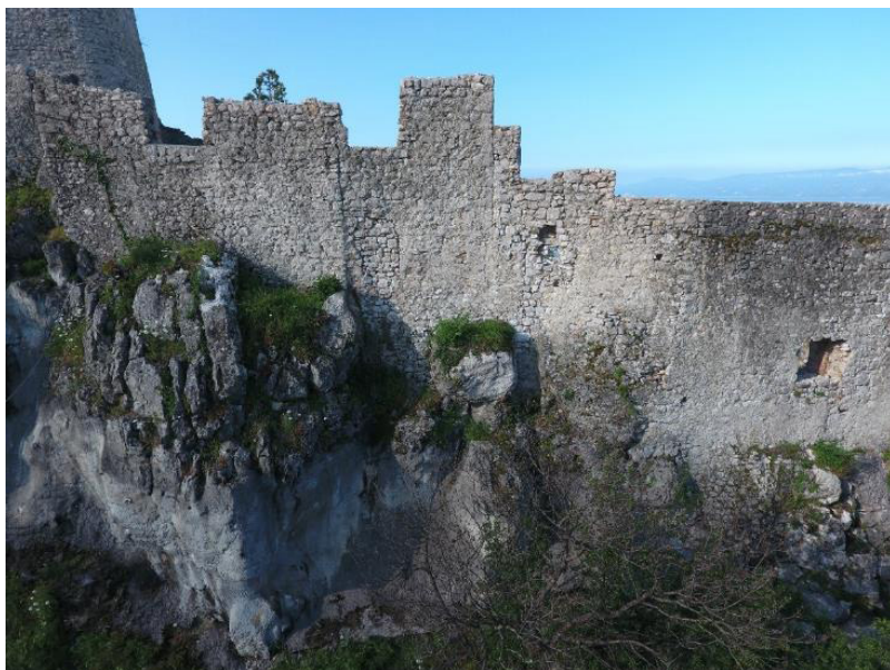
Slika 10. Sjeverni zid – uz Zapadni/stambeni dio kompleksa [7]
