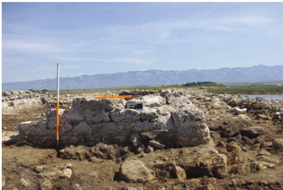
SLIKA 6. Istočni dio pročelja objekta s vidljivim pokosom (foto: J. Šučur)
