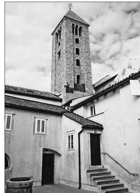
SL. 23. POGLED NA DOGRAĐENI ANEKS SA STUBIŠTEM UZA SJEVERNO KRILLO SAMOSTANA (NA KATU JE VIDLJIVA ZAZIDANA GALERIJA KRILA)
