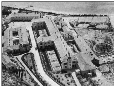
SL. 4. POGLED IZ ZRAKA NA HOTELSKI KOMPLEKS U KUPARIMA 1932. GODINE: HOTEL GRAND (DESN0), DEPENDANSA GRANDA (LIJEVO), VILA KISELA (LIJEVO U PRVOM PLANU), PENSION KUPARI / HOTEL ŠTRAND (NAJBILJE MORU) I KAVANA KABOGA (U KUTU GORE LIJEVO)
