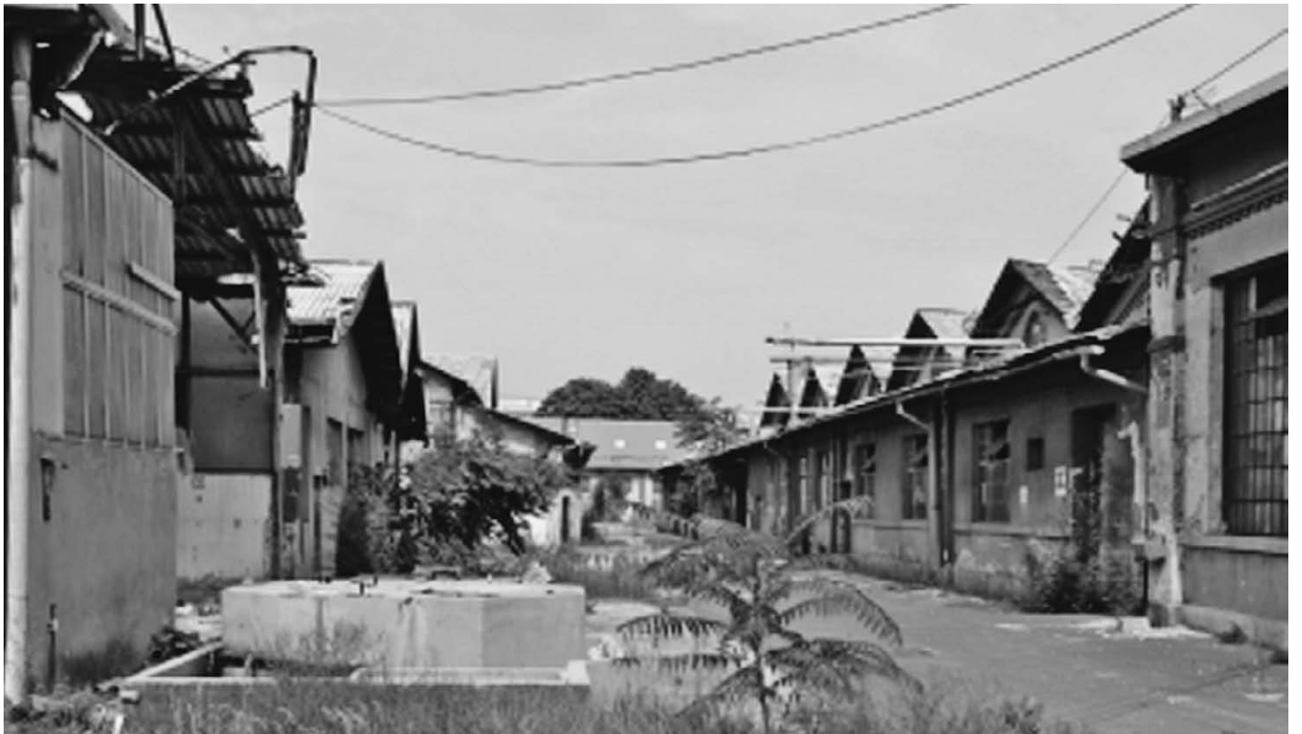
SL. 1. NAPUŠTENI PROSTOR – KOMPLEKS NEKADAŠNJE STROJARNICE DRŽAVNE ŽELJEZNICE (KASNIJE TŽV GREDELJ) U ZAGREBU
