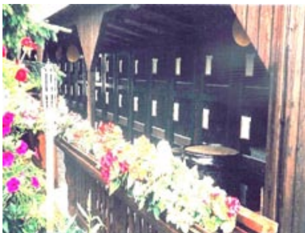
▼ Slika 4. Kuničnjak zaštićen nadstrešnicom
