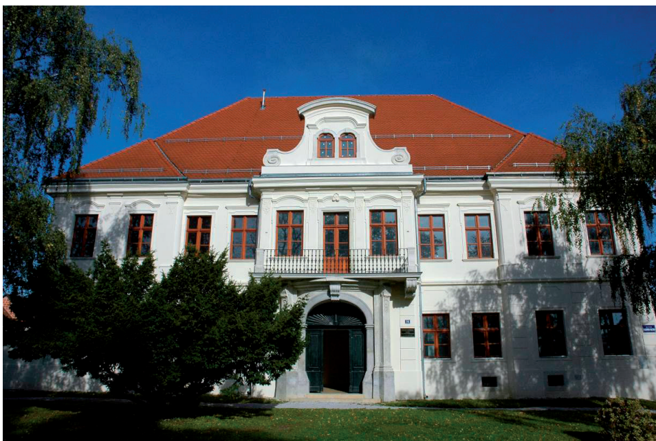
Slika 21. Pročelje nakon obnove, 2018.
