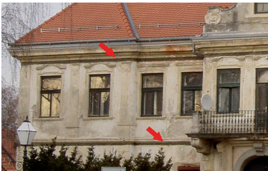
Slika 13. Ugrađena karbonska vlakna na južnom pročelju, u svrhu statičke sanacije, snimljeno 2009.
