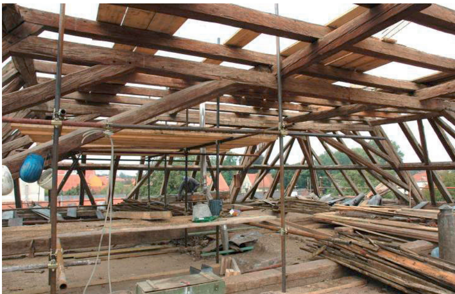
Slika 14. Razgradnja starog krovišta, 2008.
