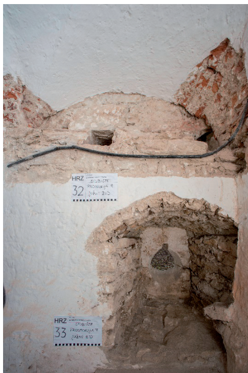
Slika 4. Nalaz zidanog dijela i ležište grede drvenog dijela hodne plohe stražarske staze te niša puškarnice. (J. Kliska, dokumentacija HRZ-a)
