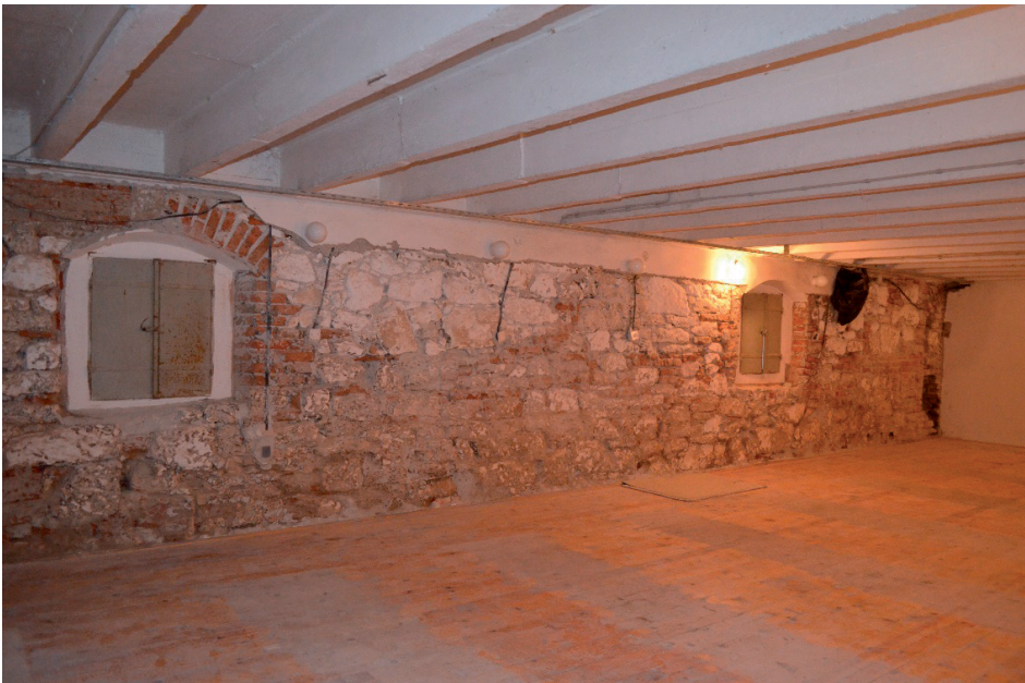
Slika 8. Niše prozora s kamenim okvirima, na sjevernom pročelju prizemlja skladišta, nakon obijanja recentne cementne žbuke i sloja hidroizolacije 2017. godine. (D. Škarpa Dubreta, dokumentacija HRZ-a)
