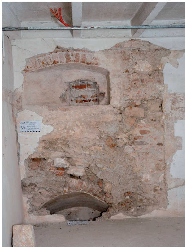
Slika 5. Puškarnica i luneta niše nekadašnjih ulaznih vrata, na katu istočne građevine (J. Kliska, dokumentacija HRZ-a)
