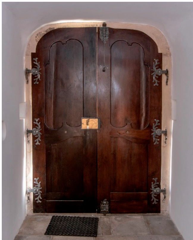
Slika 26. Vratnice glavnoga ulaza s unutarnje strane nakon radova
