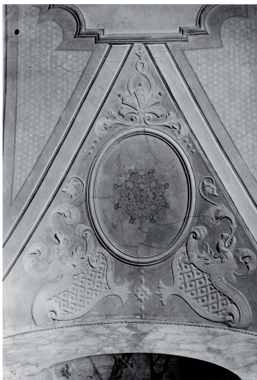
Slika 20. Detalj susvodnice na svodu u lađi s medaljonom i štukaturom, zatečeno stanje
