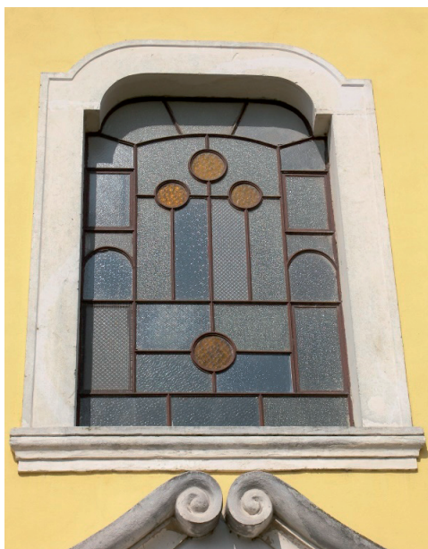
Slika 27. Prozor na glavnom pročelju prije radova
