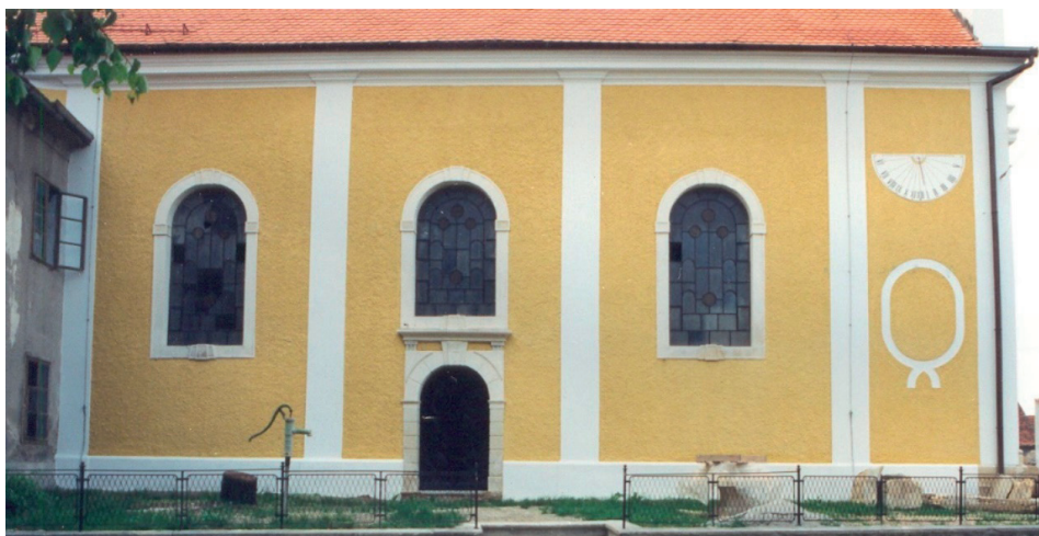
Slika 12. Južno pročelje lađe nakon radova
