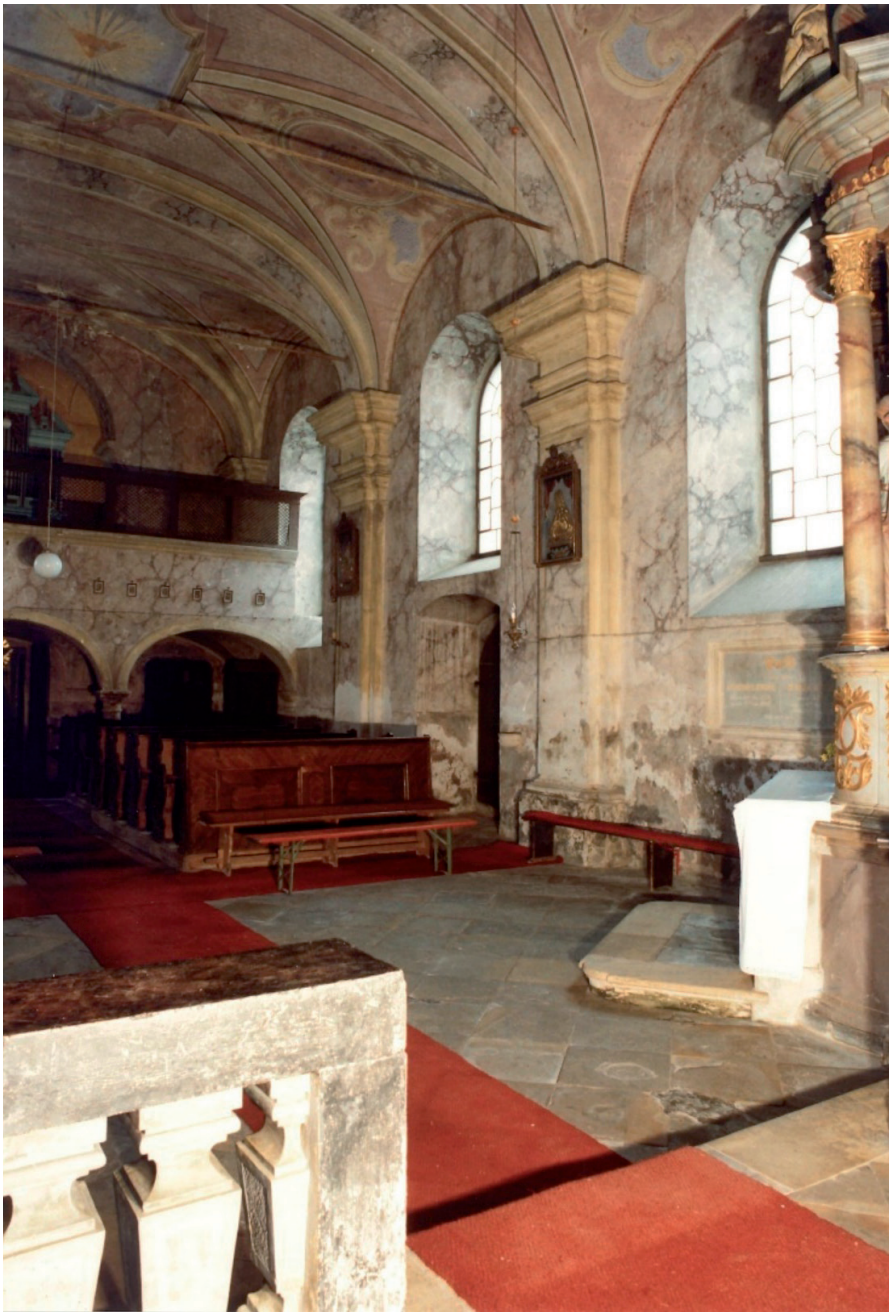
Slika 14. Unutrašnjost, pogled na južni dio crkve, zatečeno stanje
