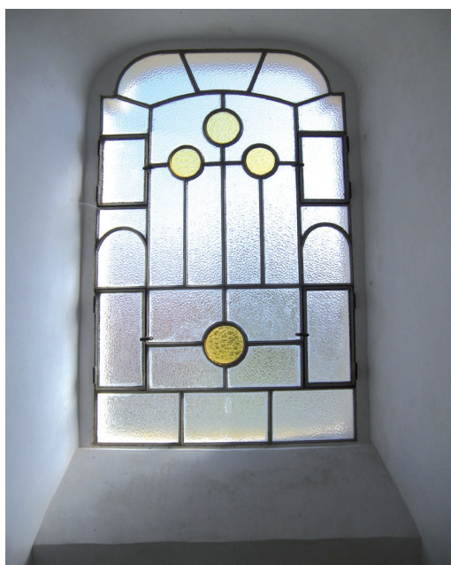
Slika 28. Prozor na glavnom pročelju nakon radova
