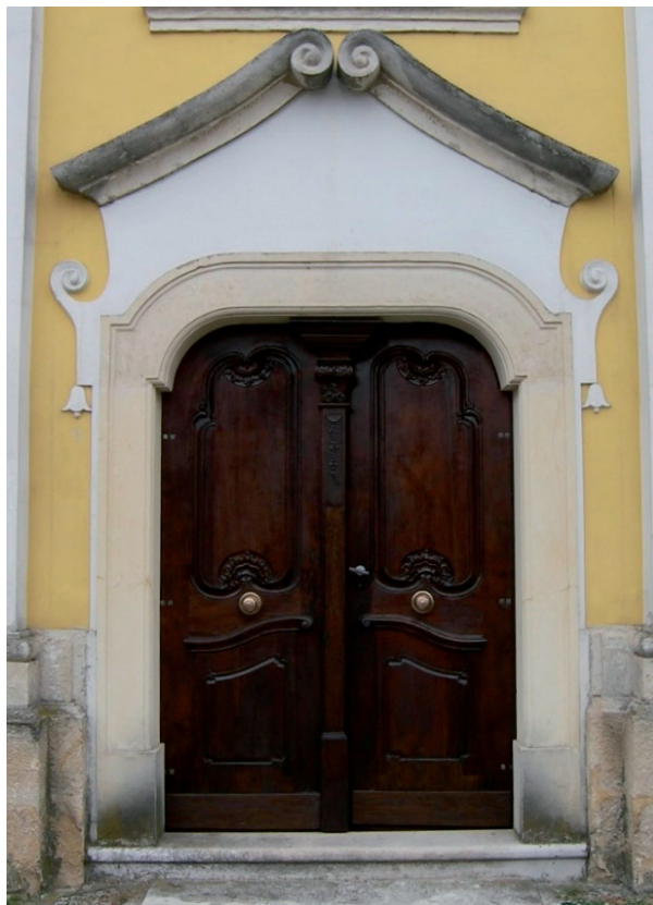
Slika 25. Glavni ulaz na istočnom pročelju nakon radova
