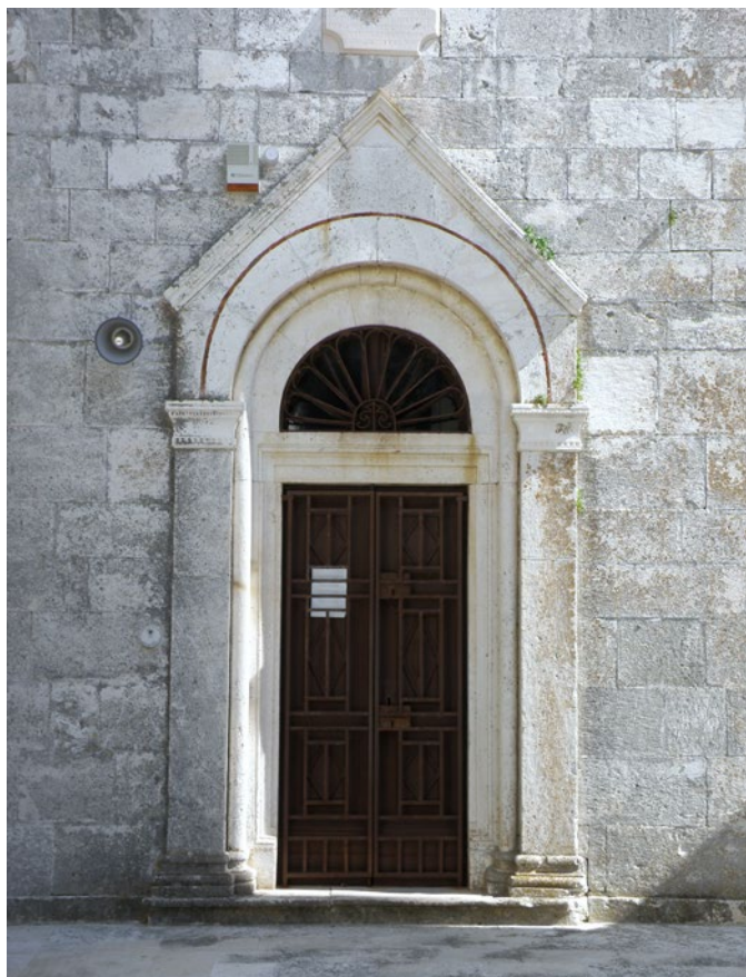
31. Portal s plitkim protironom na pročelju kapele Gospe od Zečeva do katedrale u Ninu (foto: P. Vežić)
