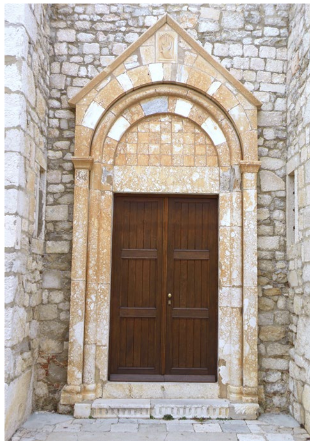
32. Portal s plitkim protironom na bočnome zidu katedrale u Krku (foto: P. Vežić)
