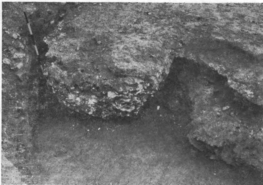
5. Gromada urušene građe, uvaljene u sedru, uz zapadni krak eksedre.
