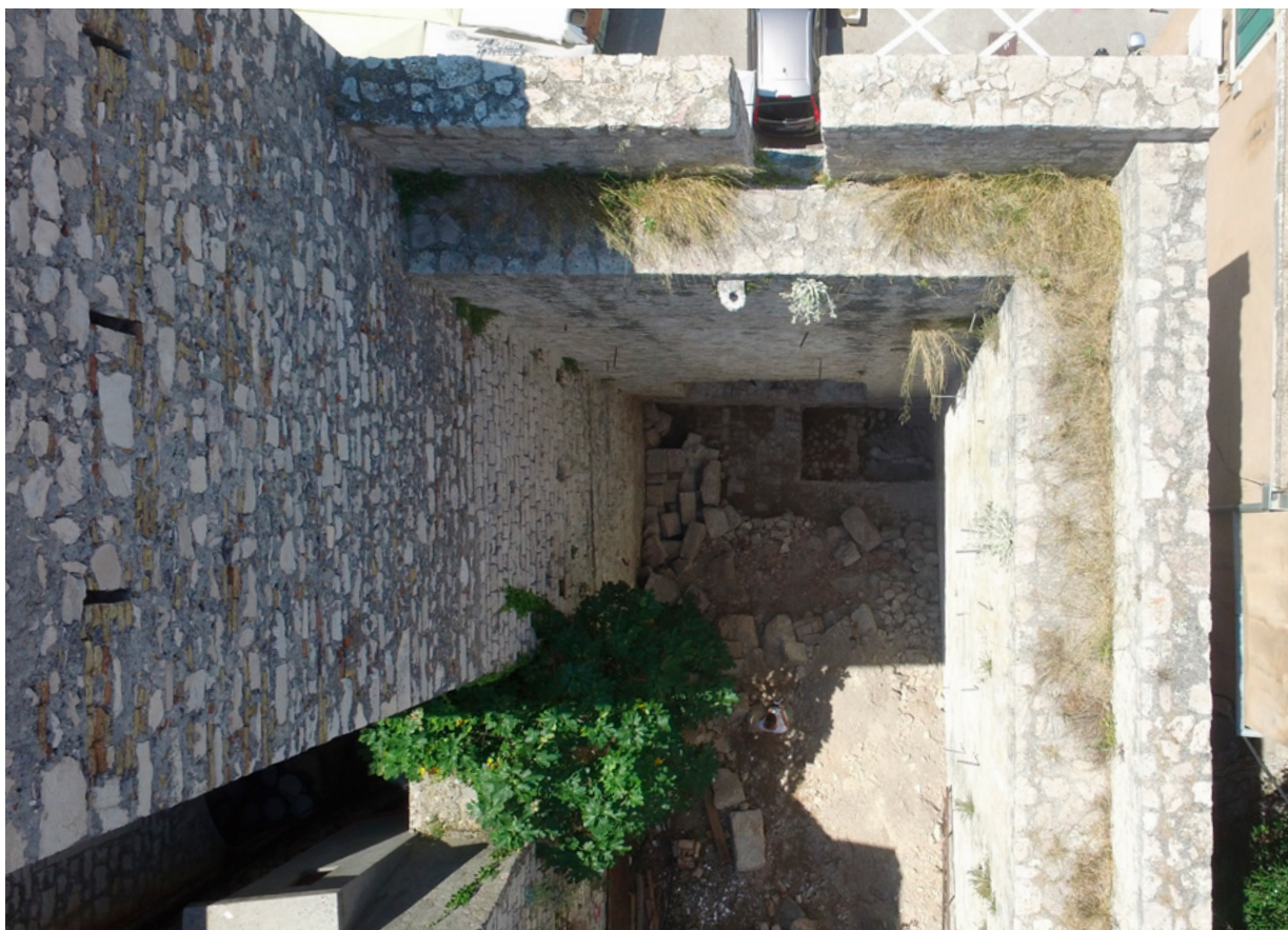
14. Šibenik, dvostruki bedem – arheološka sonda s utvrđenom podnicom iz 19. stoljeća, još starijom podnicom i živom stijenom (snimka: Arheo KO-OP, 2018.)
