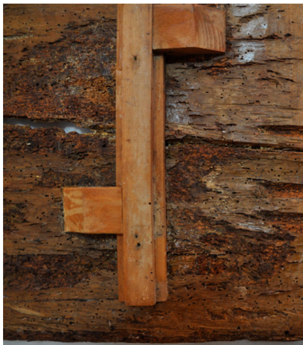
13. Detalj poledine lijeve ploče tijekom radova (fototeka HRZ-a, snimio G. Tomljenović, 2016.)
