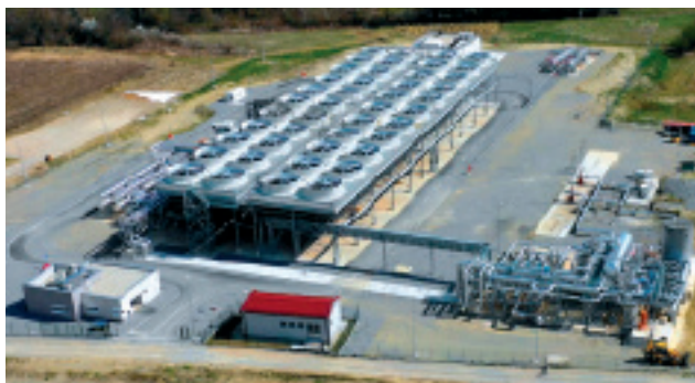
Prva geotermalna elektrana Velika Ciglena; Izvor: OIEH ( https://oie.hr/ )
