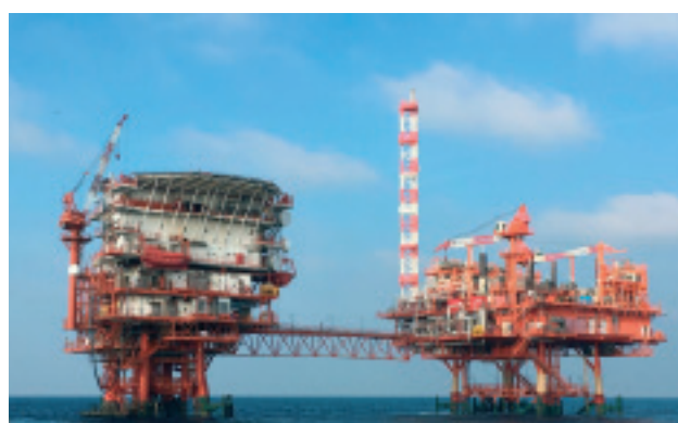
Slika 7. Proizvodna platforma Ivana A i kompresorska platforma Ivana K
