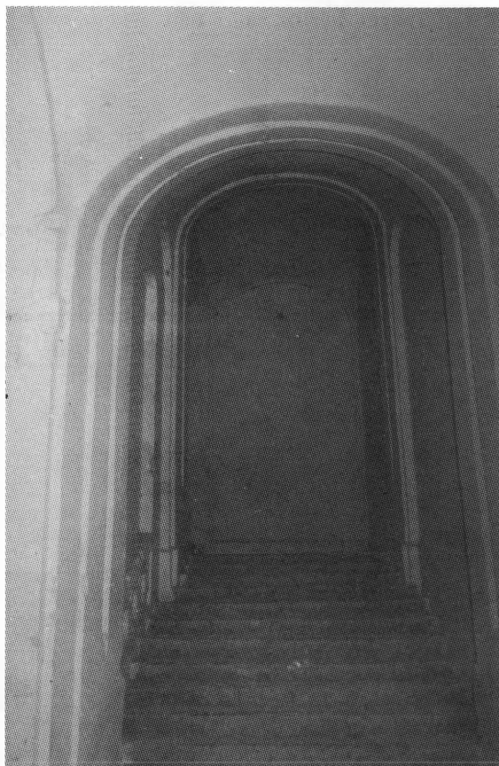
Detalj glavnog stepeništa
