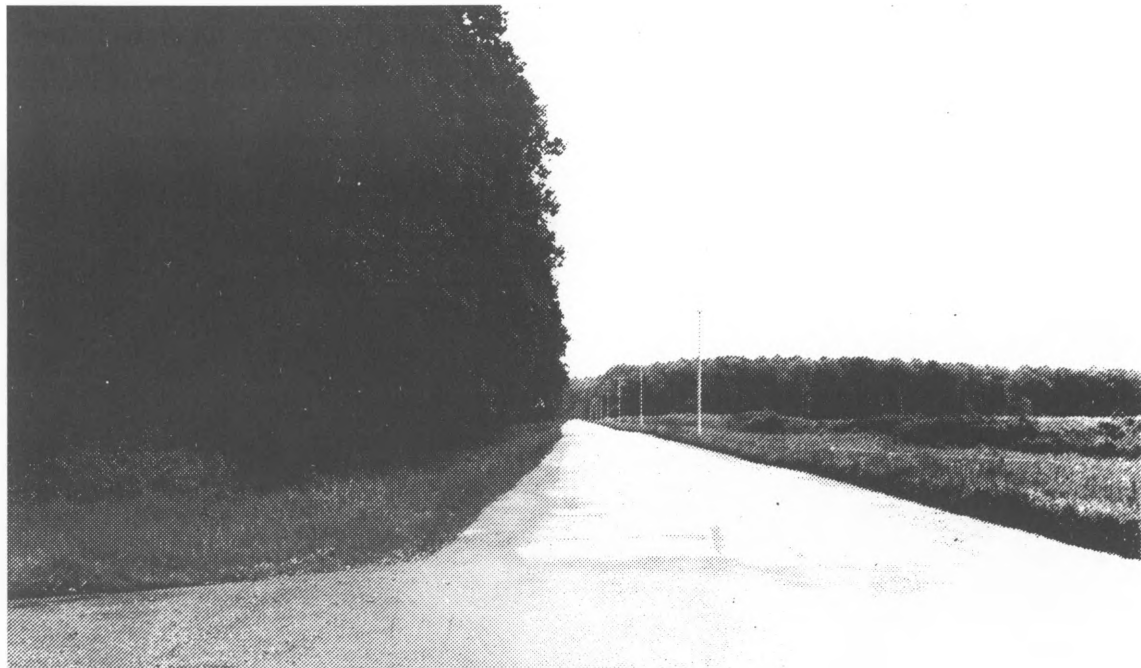
Pogled na trasu budućeg derivacijskog kanala kroz šumu Repaš
