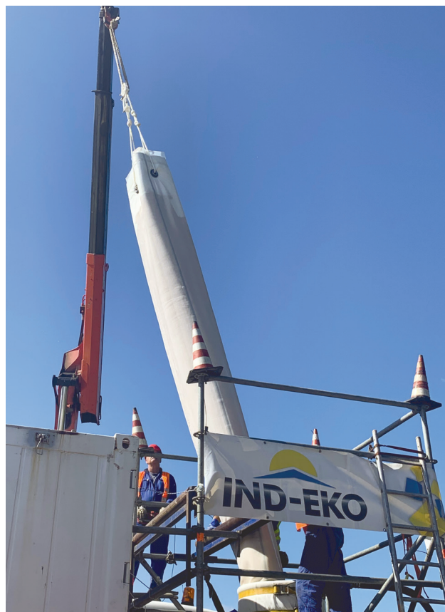
Slika 5: Uvlačenje kraja linera u postojeću cijev
