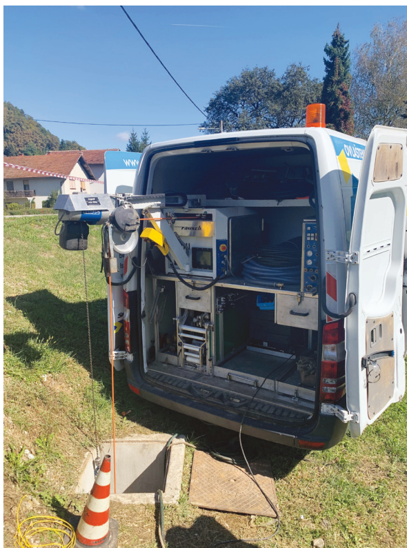
Slika 6: Izlazno okno sanirane dionice i vozilo za nadzor postupka
