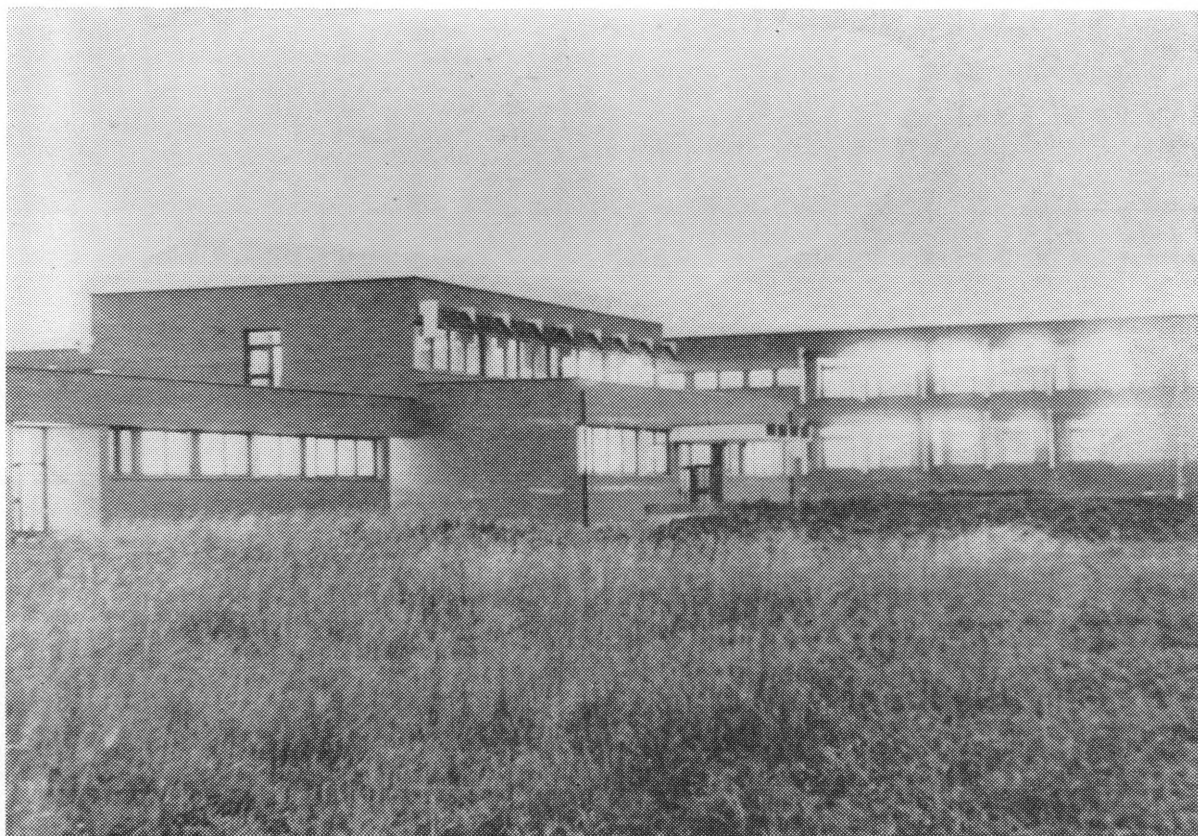
Nova zgrada Srednjoškolskog centra »Vilim Galjer« u Đurđevcu
