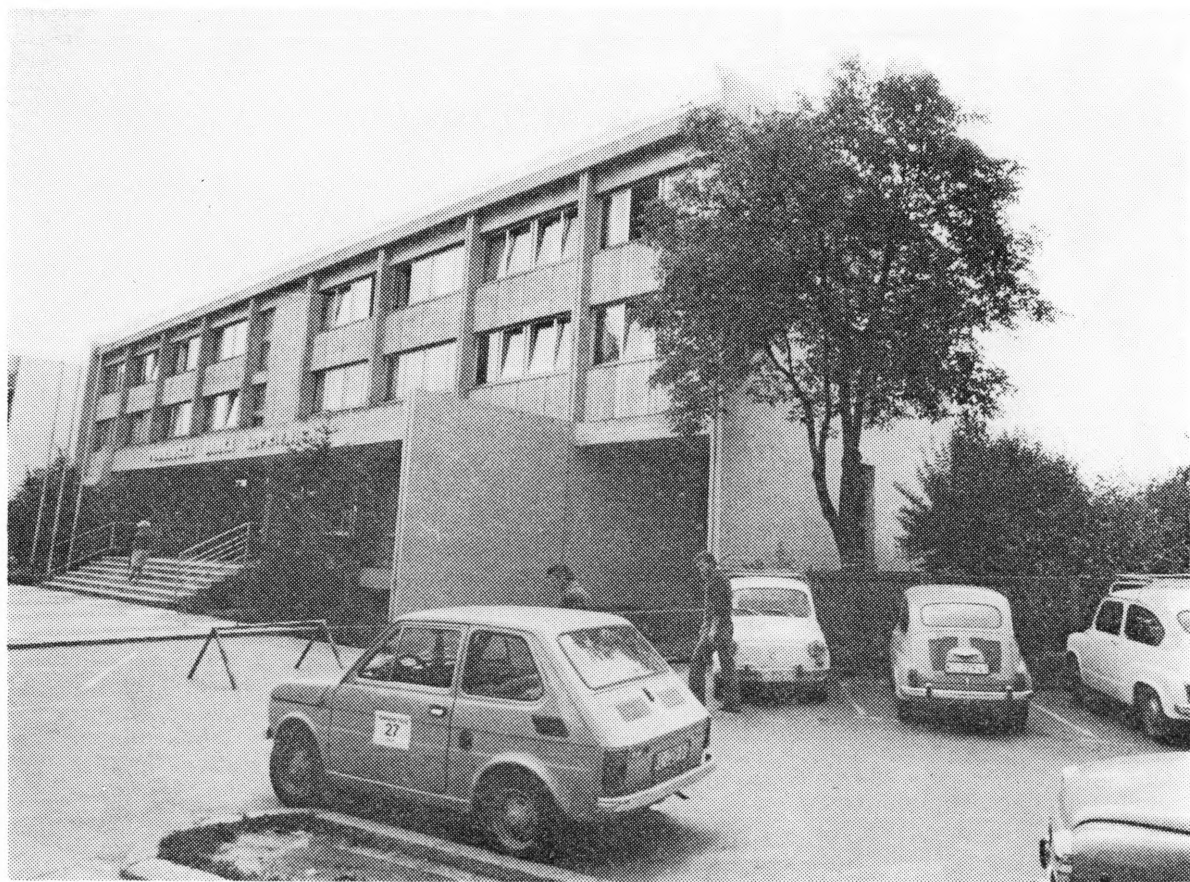
Suvremena poslovna zgrada Podravske banke u Koprivnici
