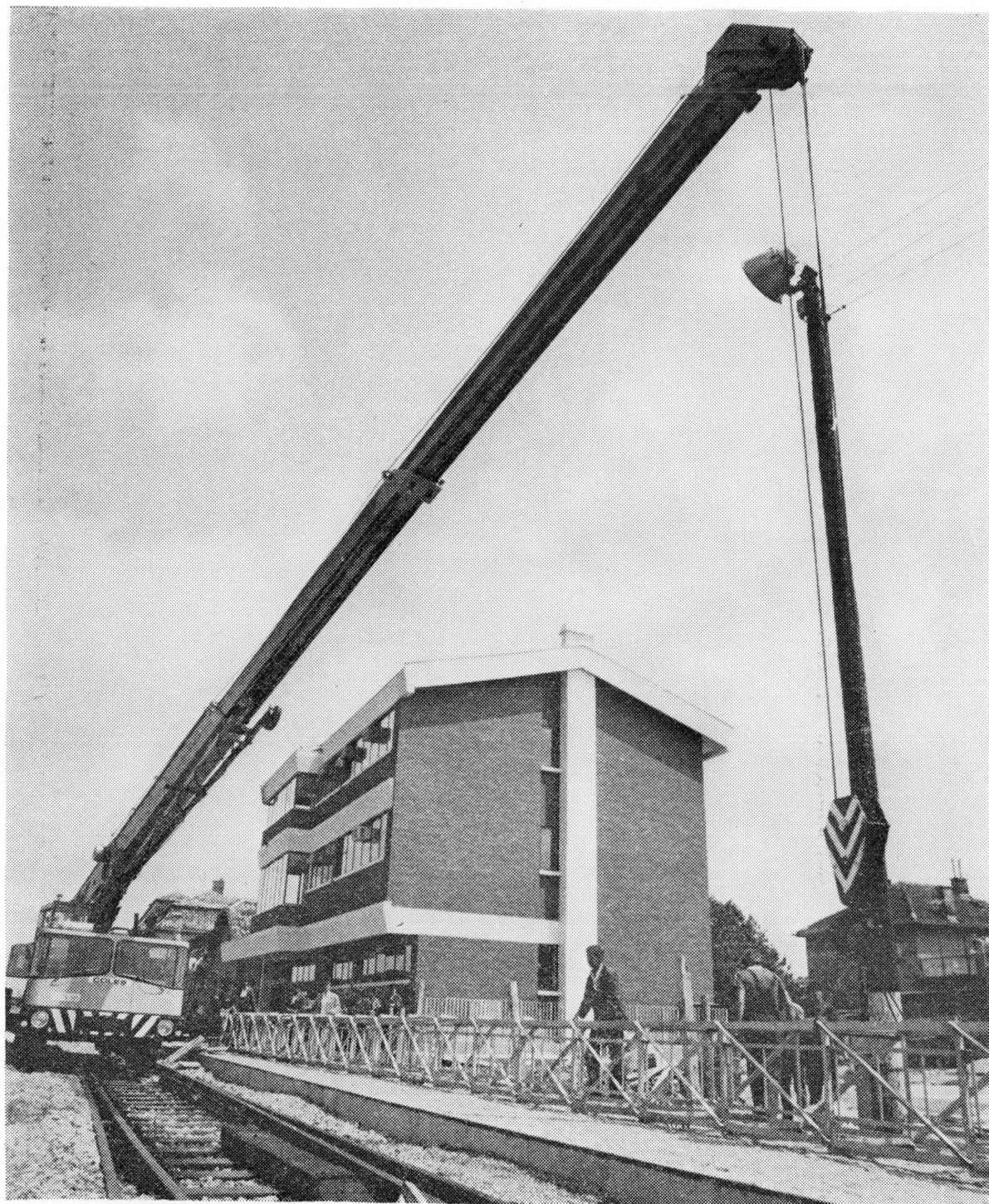
Radovi na elektrifikaciji željezničke pruge Dugo Selo — Botovo u punom su zamahu. Na slici: nova distribucijska zgrada na koprivničkom kolodvoru
