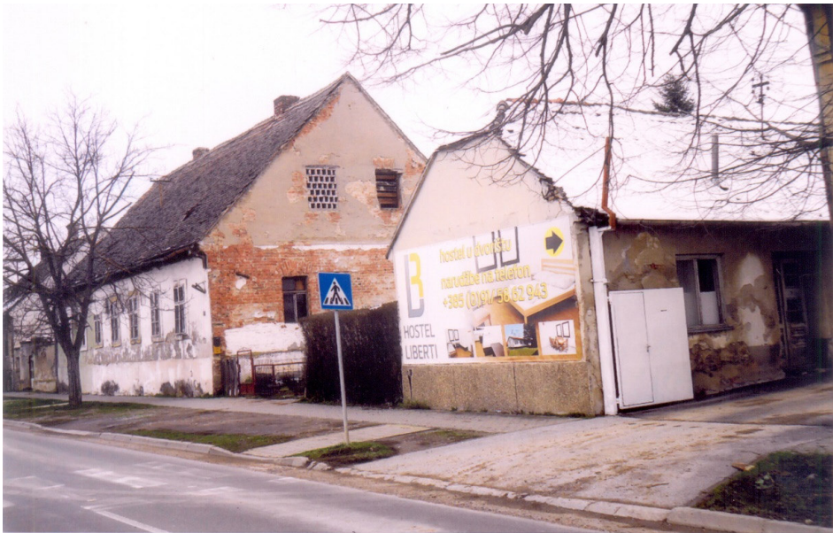
Slika 1. Zgrada direktora Karantene i ulaz u izolaciju
