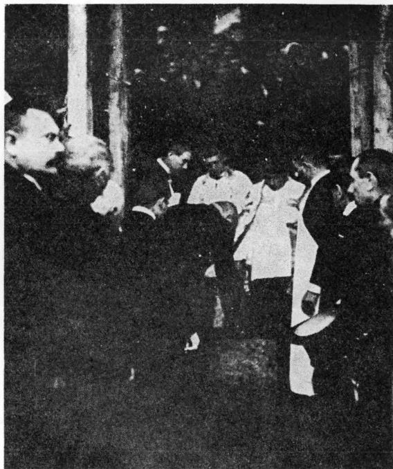
Polaganje temeljnog kamena za gimnazijsku zgradu u Koprivnici, koji je položio gradonačelnik Josip Vargović 17. studenog 1907. godine
