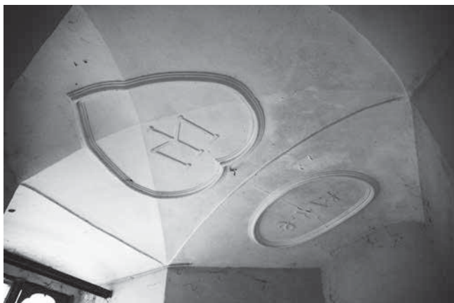
11. Štukatura na svodu u jugoistočnoj kuli, 2013. Stucco work on the southeast tower vault, 2013
