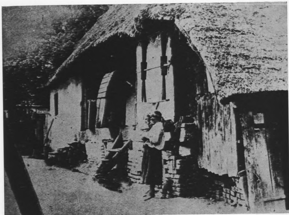
Stara seljačka kuća u Đurđevcu. Danas srušena
