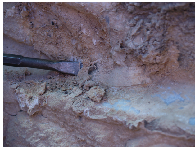
Sl. 4. Detalj uklanjanja tvrdokornih naslaga s površine sarkofaga (foto: A. Doljanin)
