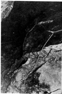
Sl. 1. Primjer grananja detonirajućeg štapina. Eksplozivno punjenje postavljeno u pukotine raspucalog bloka. Detalj iz kaverne tunela Učka
