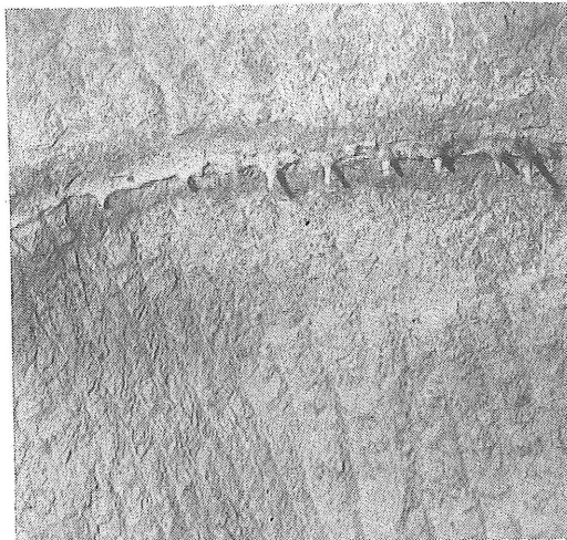
Detalj stropa tunela s tragovima dljetja kopača
