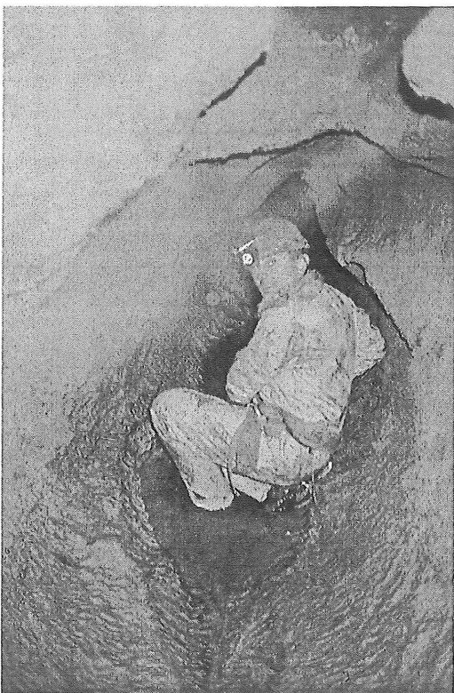
Horizontalni kanal na -102 m
