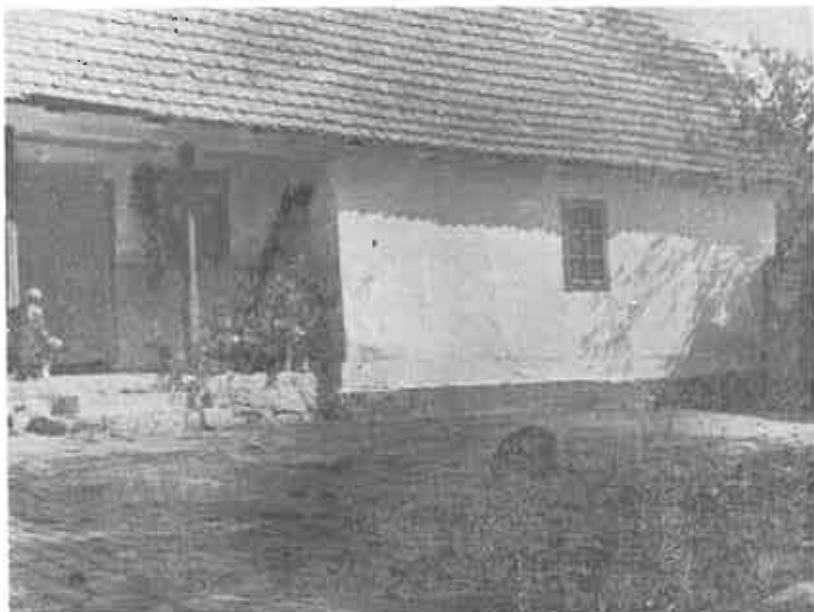
Sl. 30. Mirko Bogdanović, Gorjani, Punitovačka 1, nekada dvodjelna kuća, oko 1930. god. pregradnjom KUĆE da bi se dobila KOMORA, postala je trodjelna — Foto: Ivica Šestan
