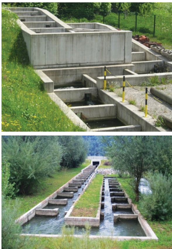
Slika 1: Riblja staza bazenskog tipa uz malu hidroelektranu u Njemačkoj; Riblja staza uz HE Blanca na Savi: staza s vertikalnim otvorima (svladavanje veće razlike u padu) prelazi u obilazni prirodni kanal / Autorica: E. Ocvirk
