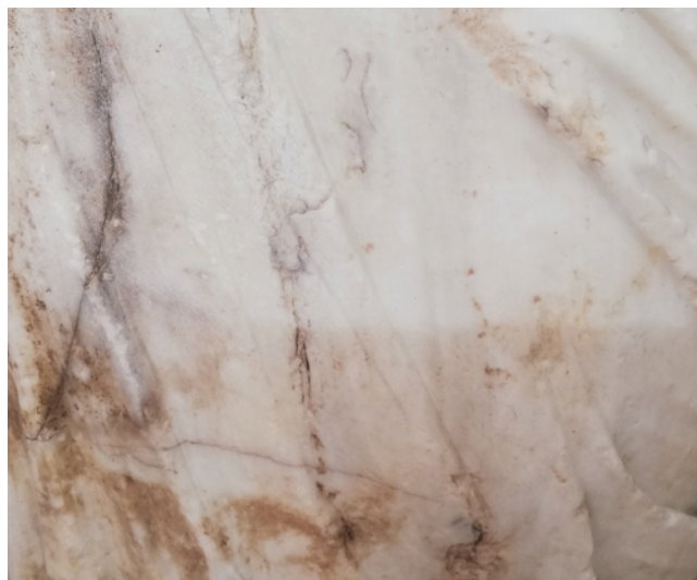
Slika 9. Rezultat čišćenja vodenom parom
