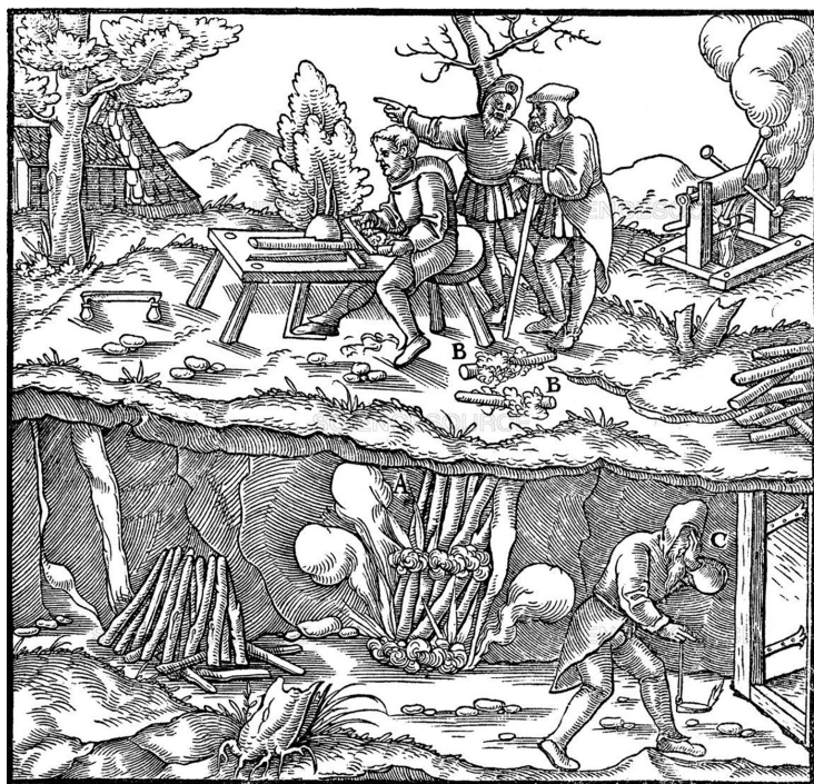
Sl. 2. Drobljenje rude paljenjem vatre [5]
