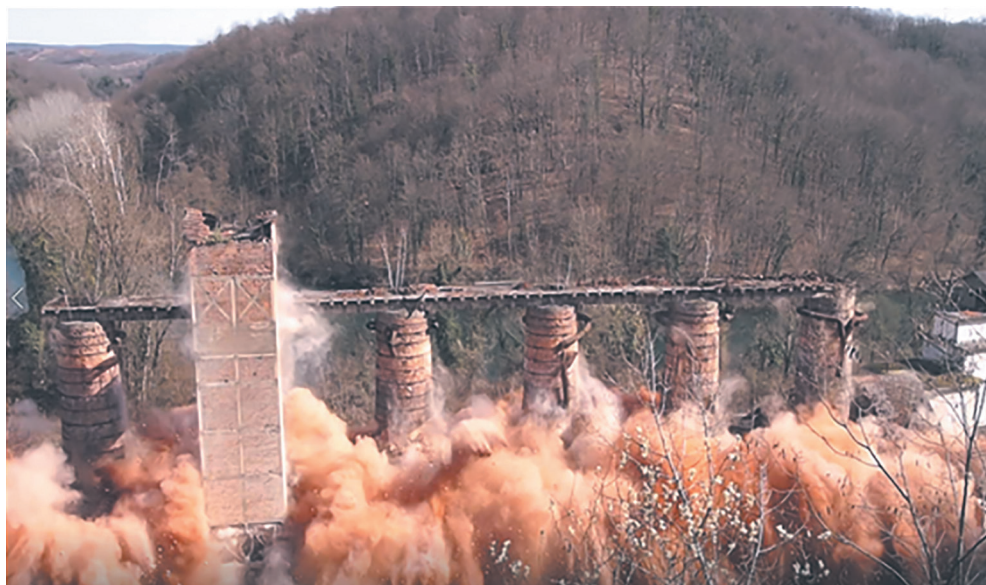
Sl. 13. Rušenje objekata vapnare miniranjem
