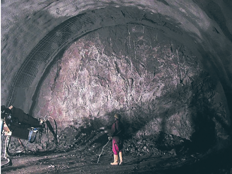
Sl. 11. Priprema minskog polja u tunelu
