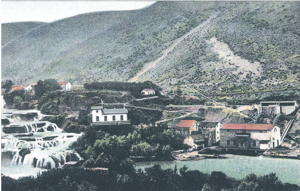
Sl. 6. Hidroelektrane Jaruga 1 i Jaruga 2 nakon izgradnje 1903. [9]
