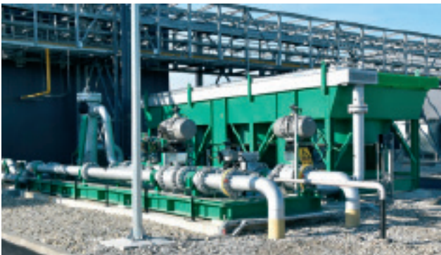
Slika 9. Ulazno-izlazni skid hladnjak
