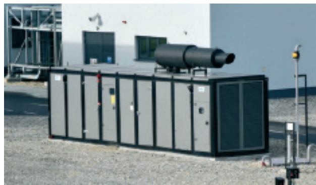
Slika 15. Dizel agregat
