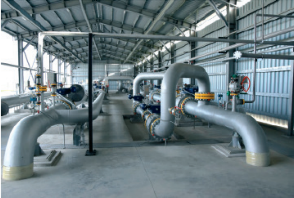
Slika 14. Ulazno–izlazna jedinica
