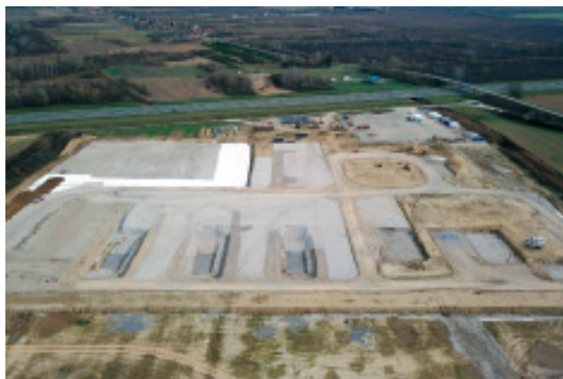
Slika 3. Izrada nasipa za predopterećenje
