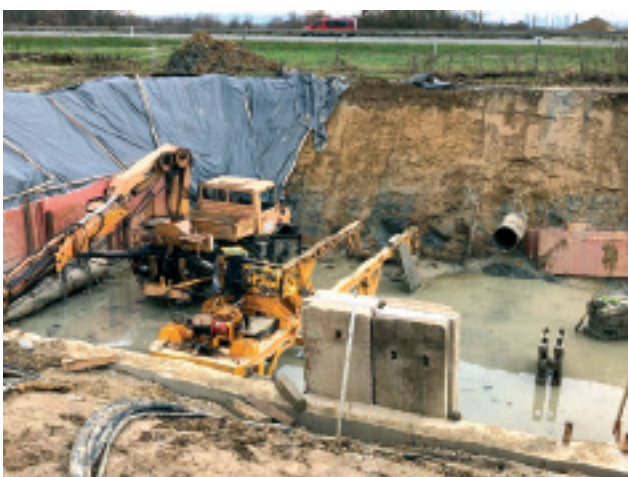
Slika 4. Bušenje prodora ispod autoceste
