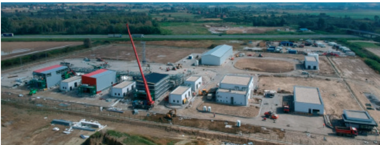
Slika 6. Gradnja kompresorske stanice
