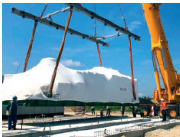
Slika 5. Doprema glavnog skida na gradilište
