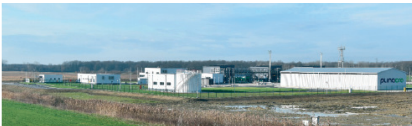
Slika 16. Kompresorska stanice nakon završetka izgradnje
