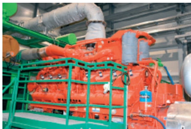
Slika 13. Plinski motor Waukesha
