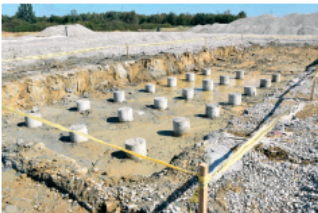
Slika 2. Ugradnja armiranobetonskih pilota ispod temelja kompresorske stanice
