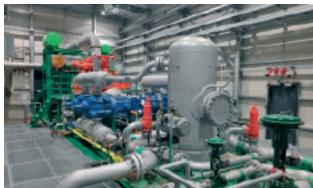
Slika 11. Kompresorski skid nakon puštanja u rad
