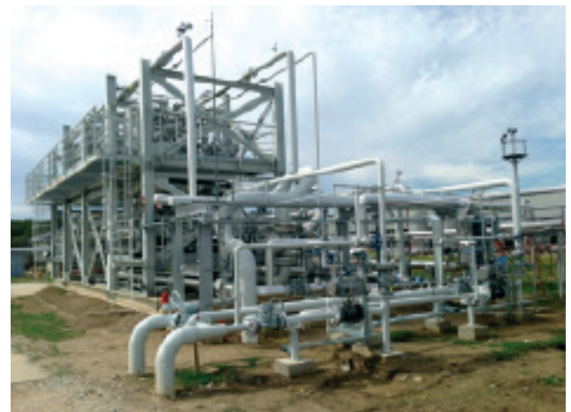
Slika 13. Membranski separatori za izdvajanje CO 2 iz prirodnog plina na KS Žutica
