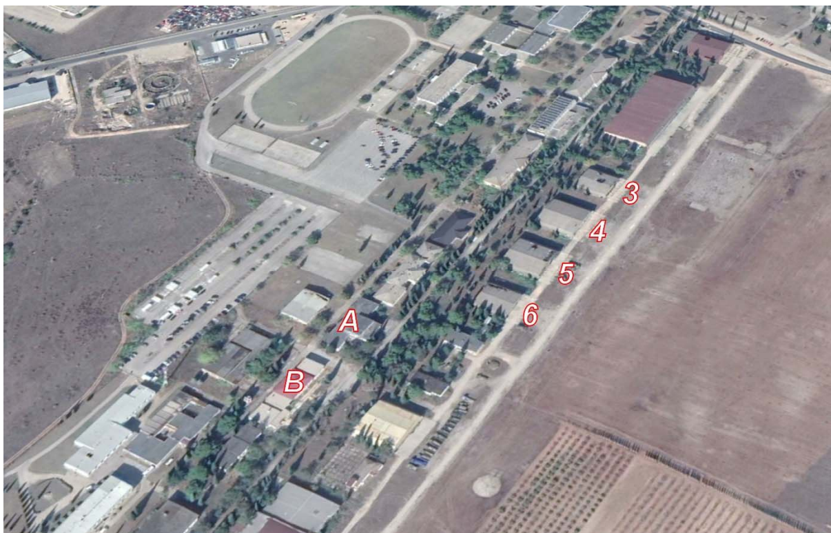
Slika 2. Suvremena slika iz zraka bivšeg uzletišta Mostar-Rodoč s jugoistoka. Očuvane k.u.k. zgrade su obilježene: br. 3 do 6 željezni hangari, A – stambena zgrada, B - radionica (Google Earth)
