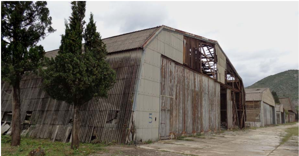
Slika 14. Waagner-hangar tipa II (br. 5) u Mostaru (M. Martinović)
