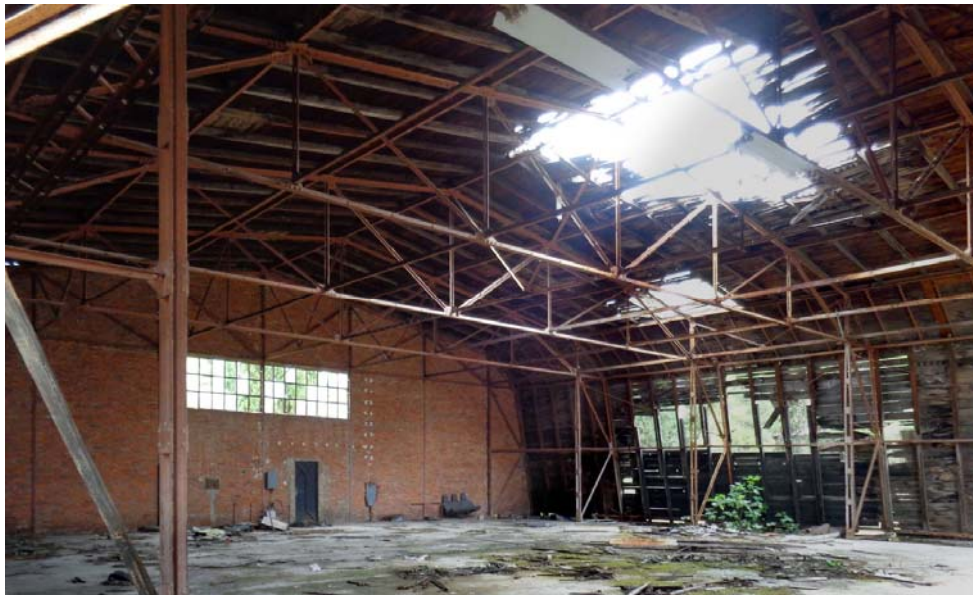
Slika 18. Hangar br. 3 s pogotkom granate. Ciglom ozidani stražnji zid ne pripada prvobitnoj konstrukciji hangara (M. Martinović)
