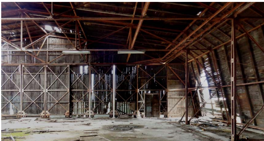
Slika 16. Hangar tipa In (br. 3) u Mostaru: željezni okviri i tračnice za elemente kliznih vrata su netaknuti (M. Martinović)
