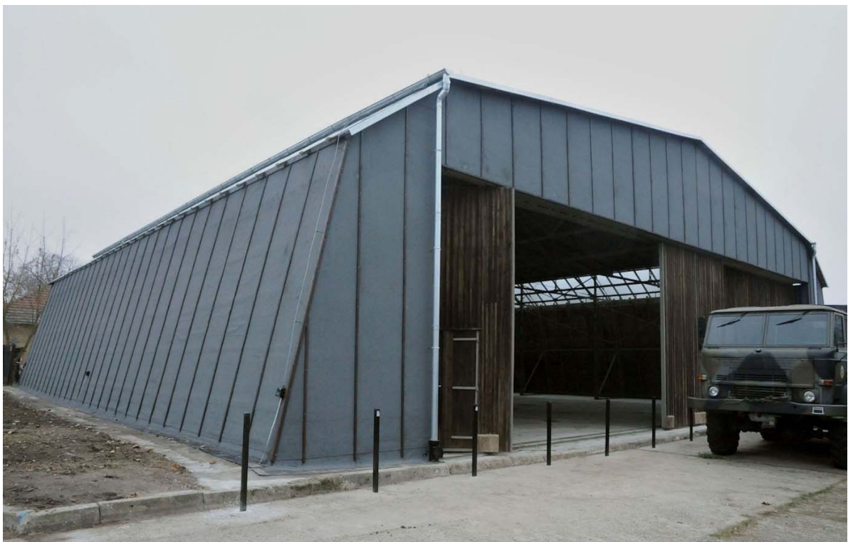
Slika 15. Besprijekorno restaurirani primjerak tipa In u Krakovu. Krovni žlijeb s olukom i gromobran su moderni, ali „dodatci“ koji imaju smisla
