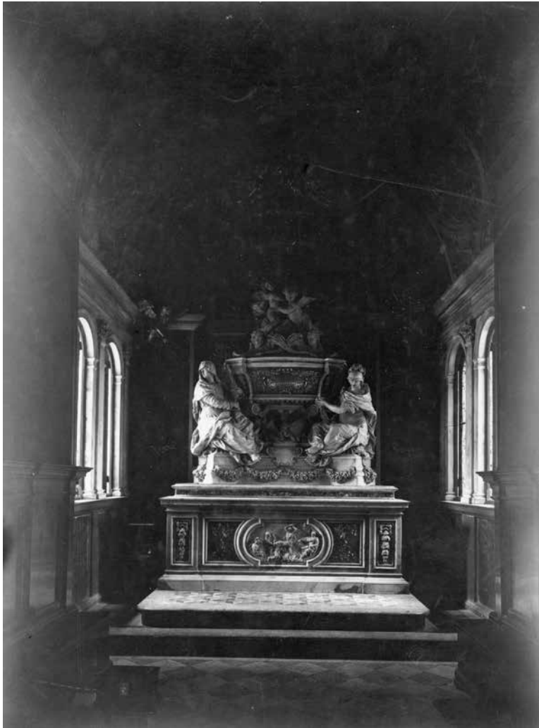
Izvorni izgled unutrašnjeg prostora baroknog oltara prije godine 1924. (Split, Konzervatorski odjel, arhiv fotografija, B. inv. 3100)
