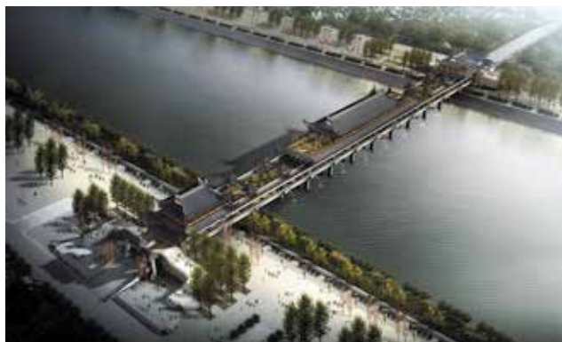
Slika 1. Prikaz mosta Liyutuo Lounge
