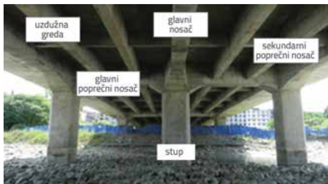
Slika 12. Stup mosta, glavni nosač i glavni poprečni nosač
