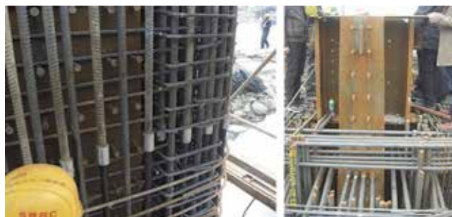
Slika 9. Raspored profiliranog čelika i armature stupa
