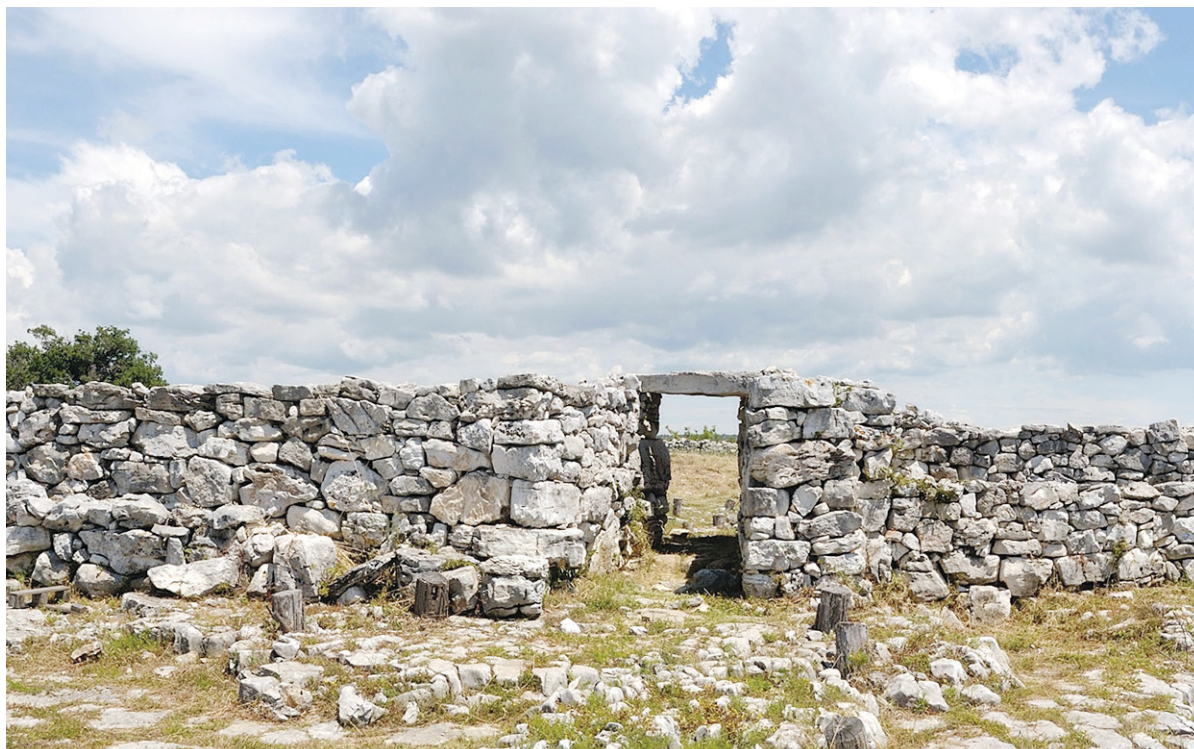
SLIKA 10. Monkodonja, pogled na vanjsku stranu zapadnog bedema akropole s restauriranim južnim vratima koja su ostala u funkciji kroz cijelo vrijeme trajanja naselja (foto: O. Thiel).
