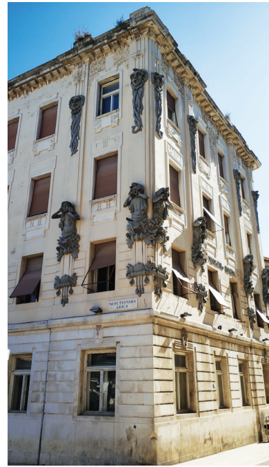
Slika 18: Zgrada sumpornog kupališta (snimila: B. Beović)
