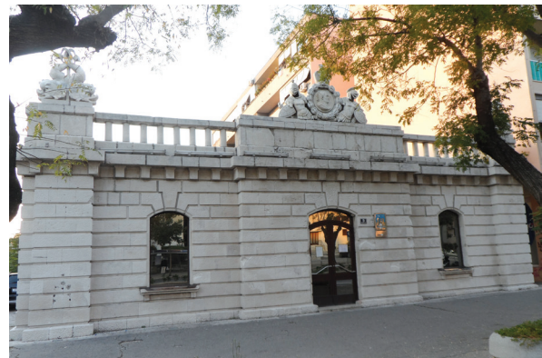
Slika 2: Zasunska komora vodospreme obnovljenog Dioklecijanovog vodovoda (snimila: B. Beović)
