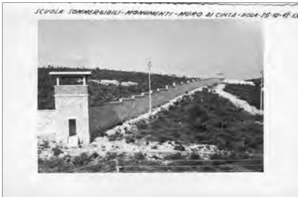
Fig. 2 - Il tratto di cinta di Monumenti tra la torre 3 e 4, in fase di ultimazione nell'ottobre 1942 (PPMI-44564)
